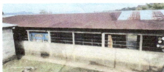
Foto 5: Techo de las aulas 1,2, y 3, se encuentran en mal estado, se necesita cambio.
